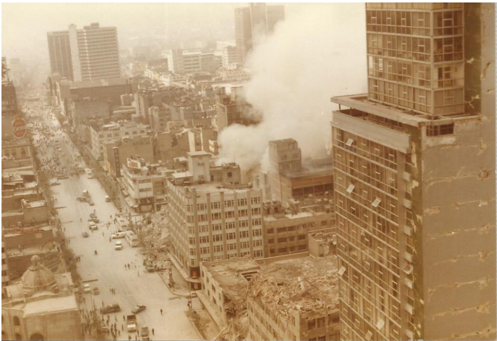
FOTO 30. DERRUMBE DE 6 PISOS DEL EDIFICIO ATLAS Y TOTAL DEL SUPERLECHE. 19 DE SEPTIEMBRE DE 1985.
