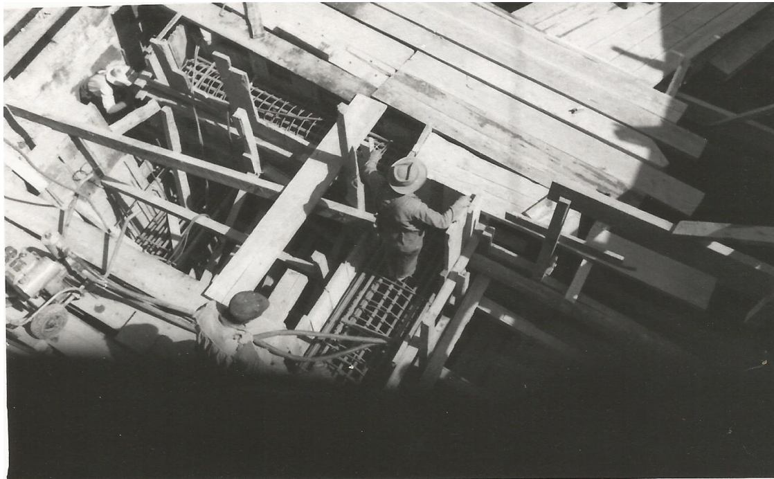
FOTO 16. COLADO DE TRABES DE CIMENTACIÓN.
