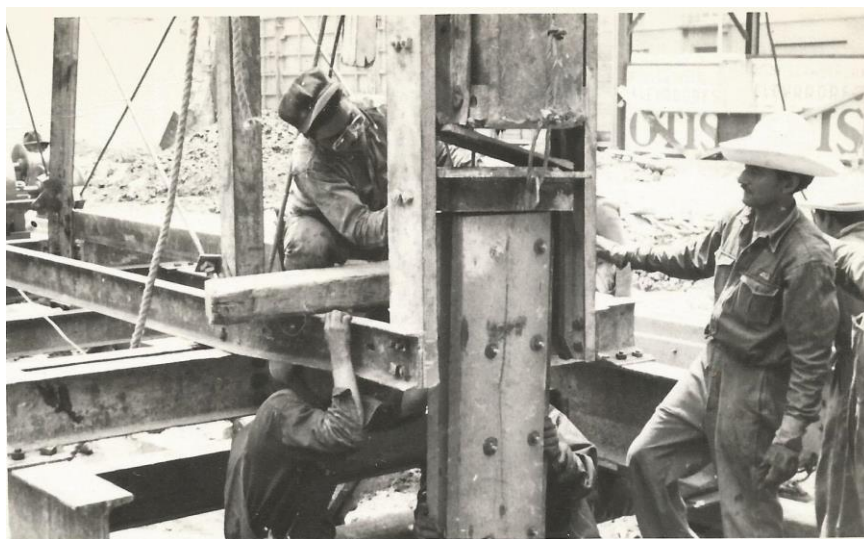
FOTO 10. ATAGUÍA MACHIMBRADA DE LA CIMENTACIÓN.
