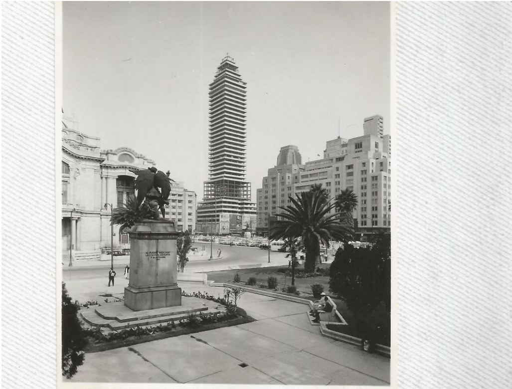
FOTO 23. NÓTESE LOS PISOS SIN COLAR, PARA EVITAR ESFUERZOS ADICIONALES.
