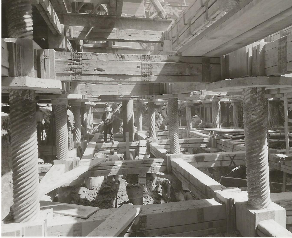
FOTO 11. HILERAS DE PILOTES DE APOYO AL CONTRAVENTE.
