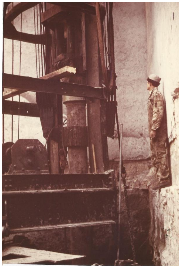
FOTO 4. PILOTEADORA Y PERSONAL DE OPERACIÓN.
