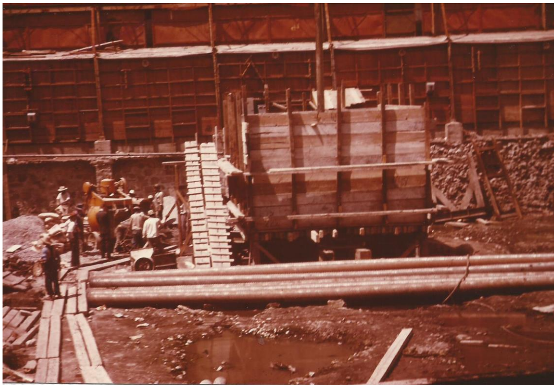
FOTO 8. PRUEBA DE CARGA DE PILOTES A 80 TONELADAS.
