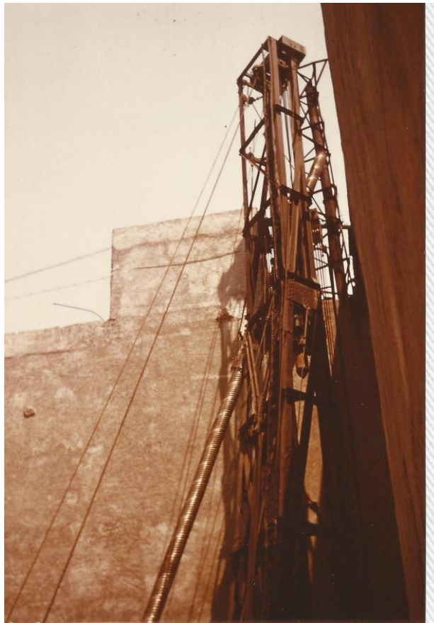
FOTO 6. CAMISA DE TUBO CORRUGADO DE CADA PILOTE.
