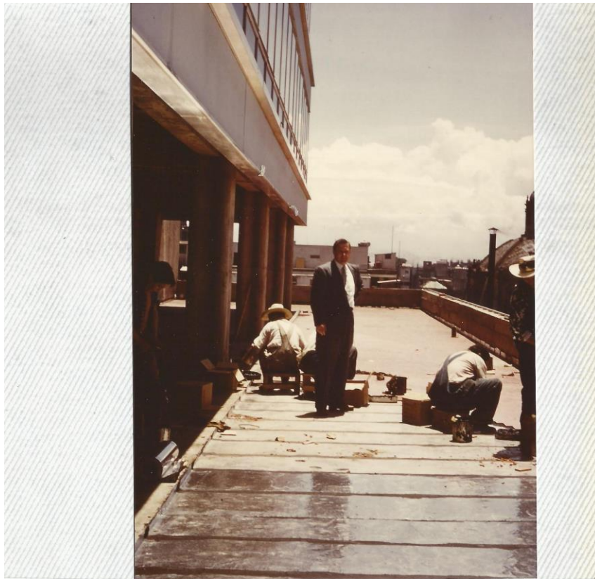
FOTO 28. EL CONSTRUCTOR SUPERVISANDO LA IMPERMEABILIZACIÓN DE TERRAZAS.
