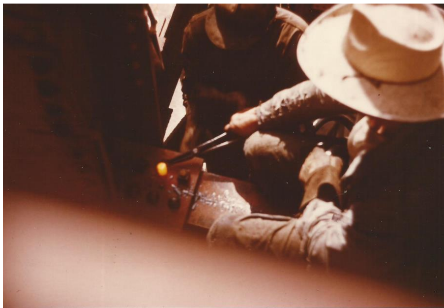
FOTO 22. LA ESTRUCTURA FUÉ REMACHADA EN SU TOTALIDAD.
