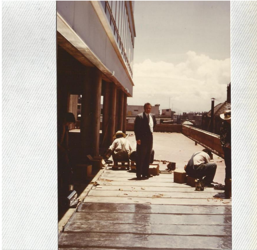
FOTO 28. EL CONSTRUCTOR SUPERVISANDO LA IMPERMEABILIZACIÓN DE TERRAZAS.
