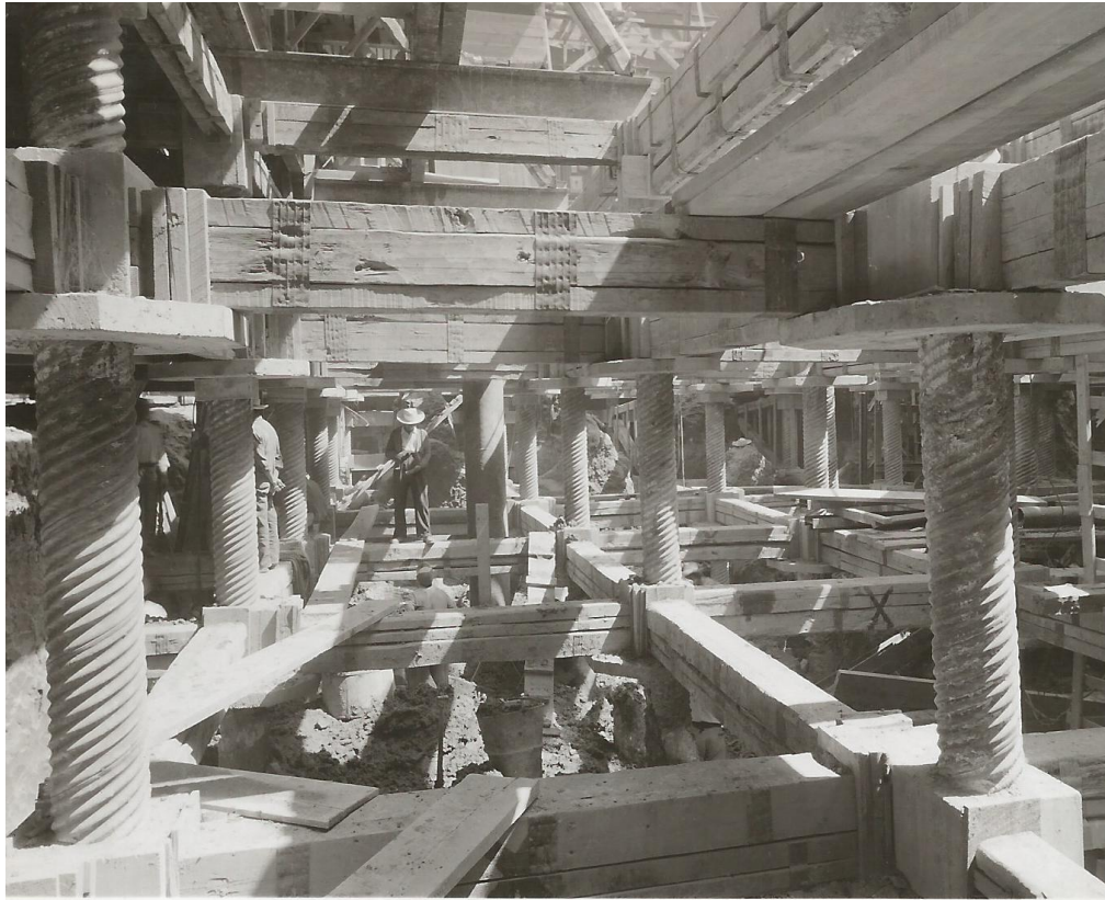
FOTO 11. HILERAS DE PILOTES DE APOYO AL CONTRAVENTE.
