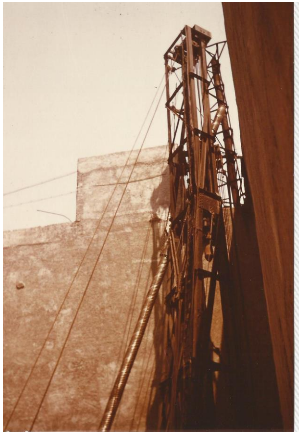
FOTO 6. CAMISA DE TUBO CORRUGADO DE CADA PILOTE.
