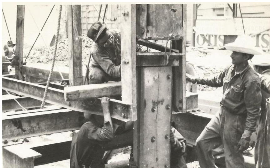
FOTO 10. ATAGUÍA MACHIMBRADA DE LA CIMENTACIÓN.
