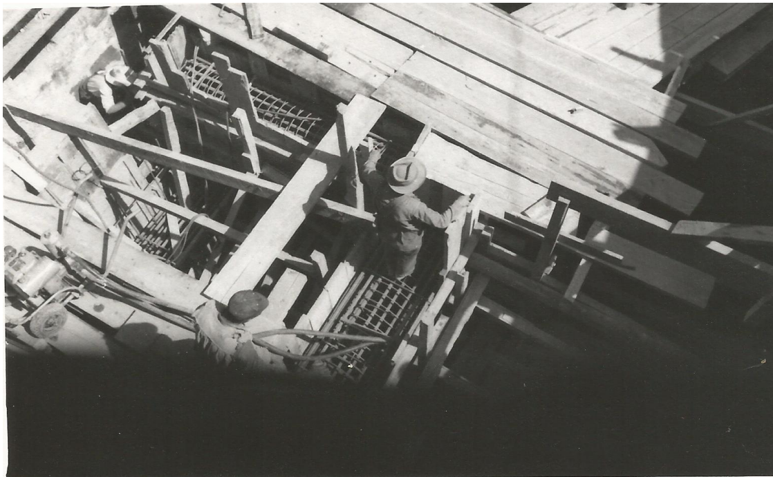
FOTO 16. COLADO DE TRABES DE CIMENTACIÓN.
