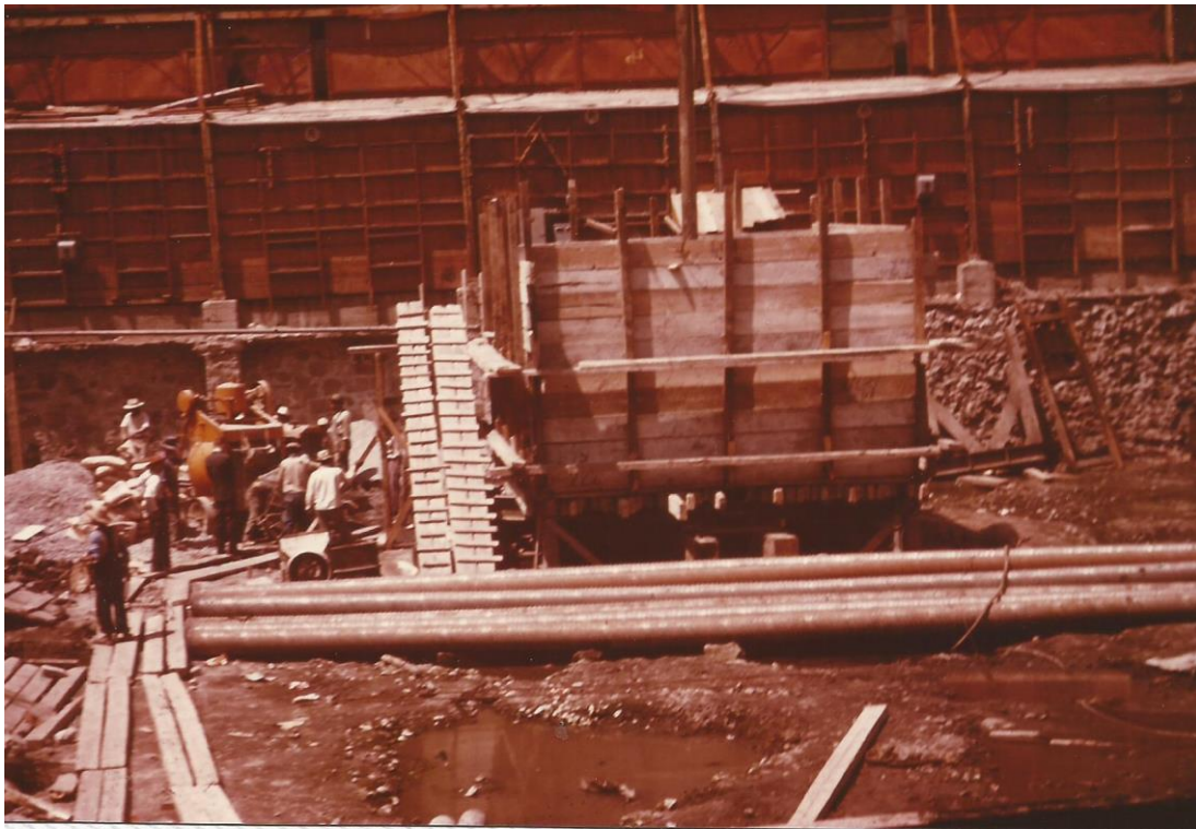
FOTO 8. PRUEBA DE CARGA DE PILOTES A 80 TONELADAS.
