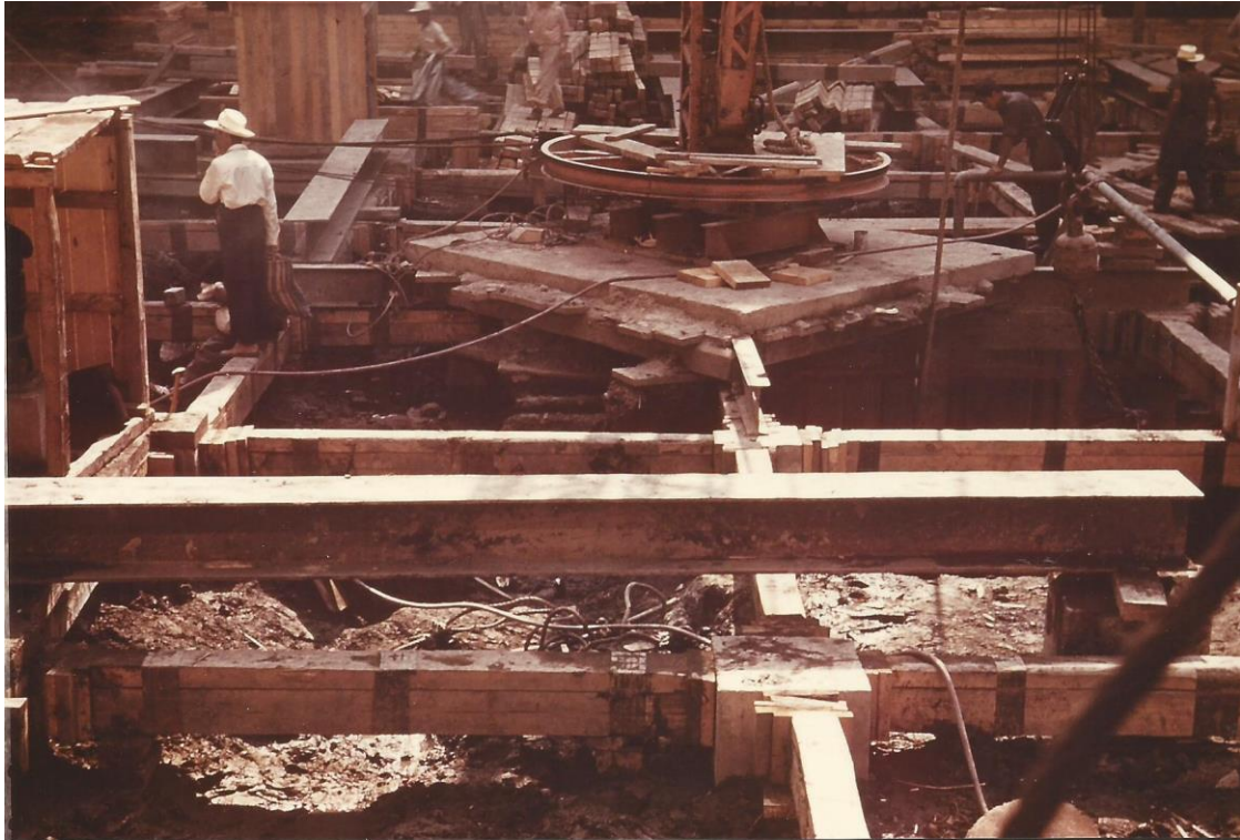
FOTO 15. COLOCACIÓN DE VIGUETAS DE APOYO.
