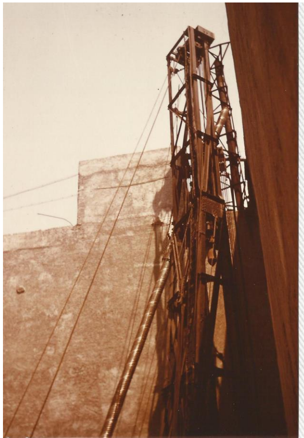
FOTO 6. CAMISA DE TUBO CORRUGADO DE CADA PILOTE.
