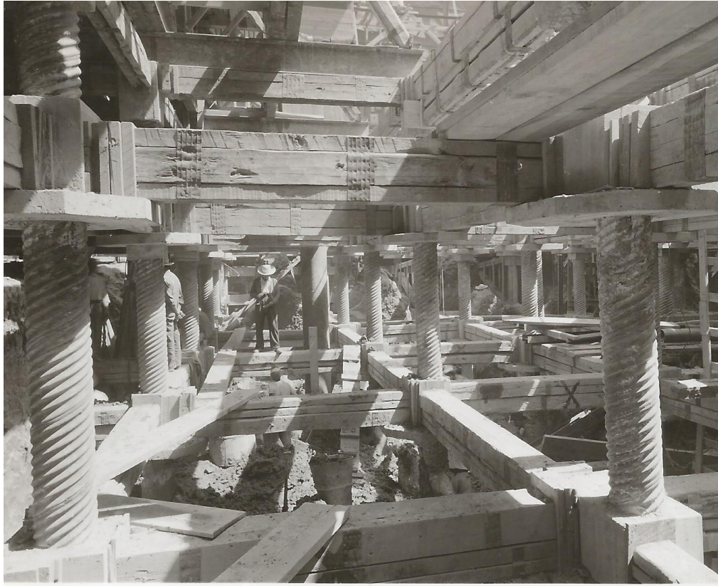
FOTO 11. HILERAS DE PILOTES DE APOYO AL CONTRAVENTE.
