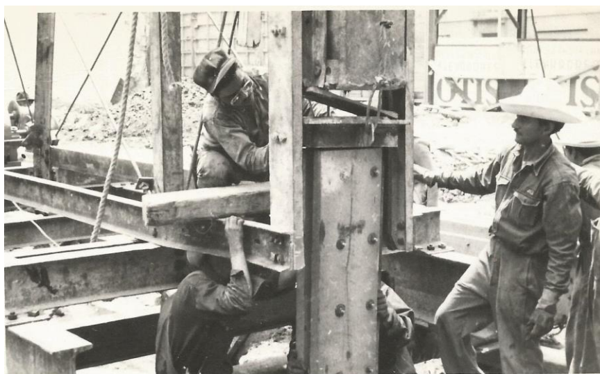
FOTO 10. ATAGUÍA MACHIMBRADA DE LA CIMENTACIÓN.
