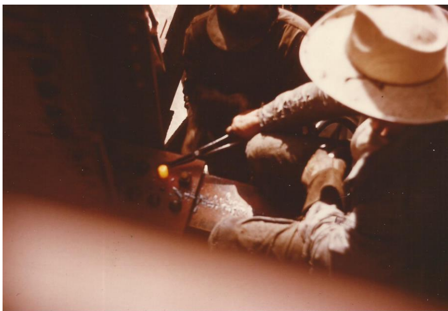
FOTO 22. LA ESTRUCTURA FUÉ REMACHADA EN SU TOTALIDAD.
