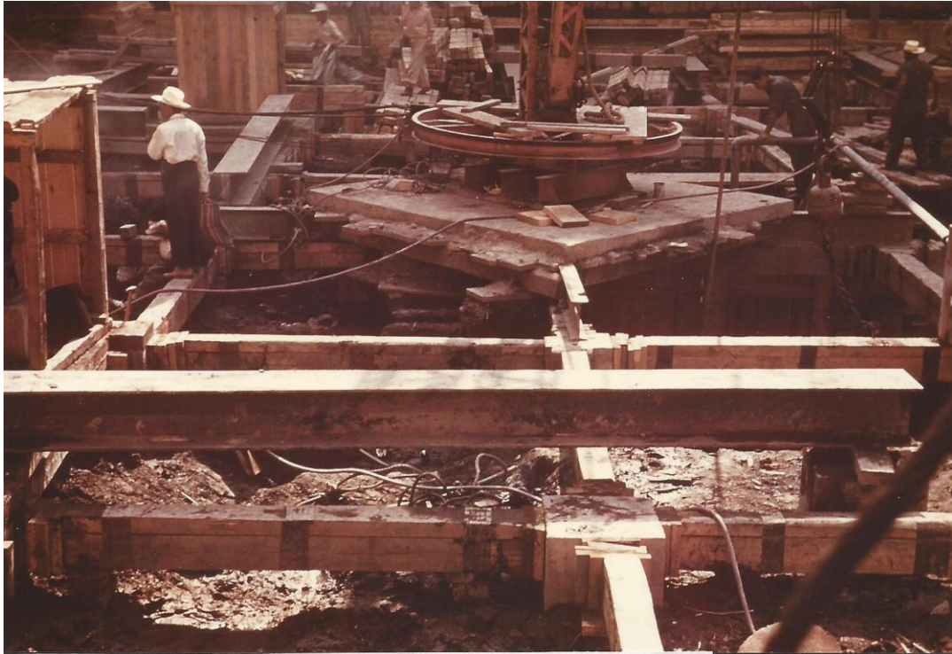
FOTO 7. SOPORTES DE GRÚA DE MONTAJE.
